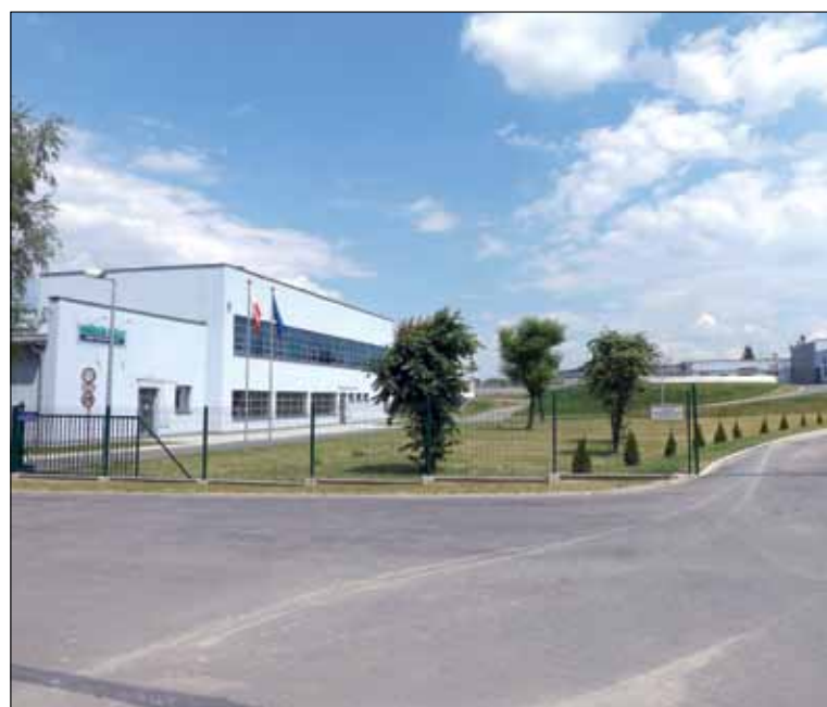
Oczyszczalnia ścieków w Tuchowie.
