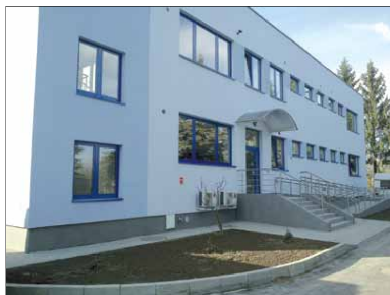
Stacja uzdatniania wody Lubaszowa.
