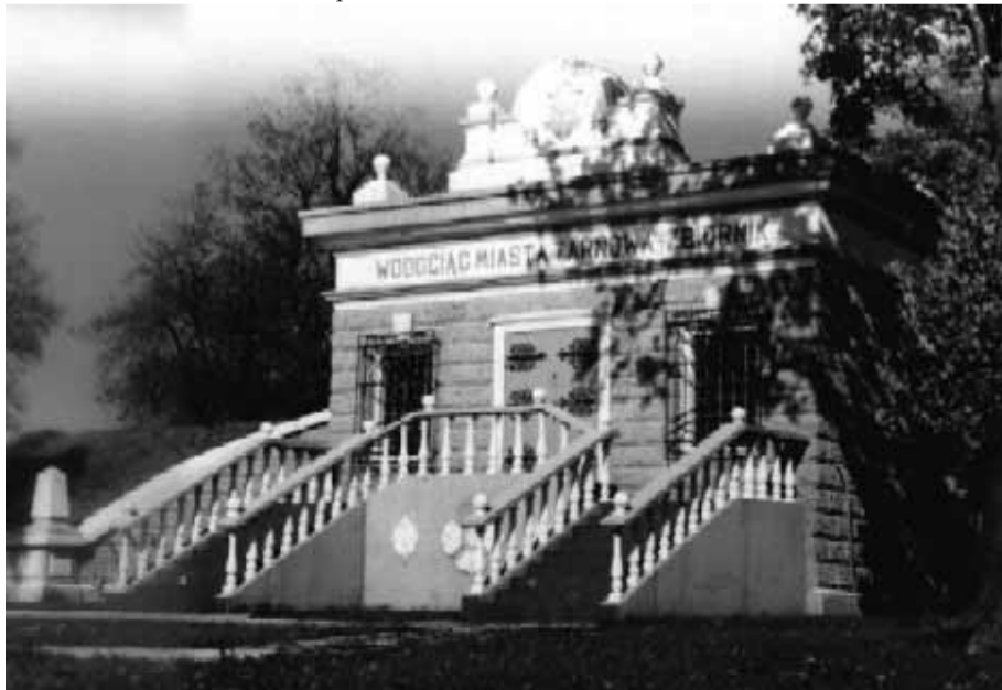
Zbiornik Tarnowskich Wodociągów
