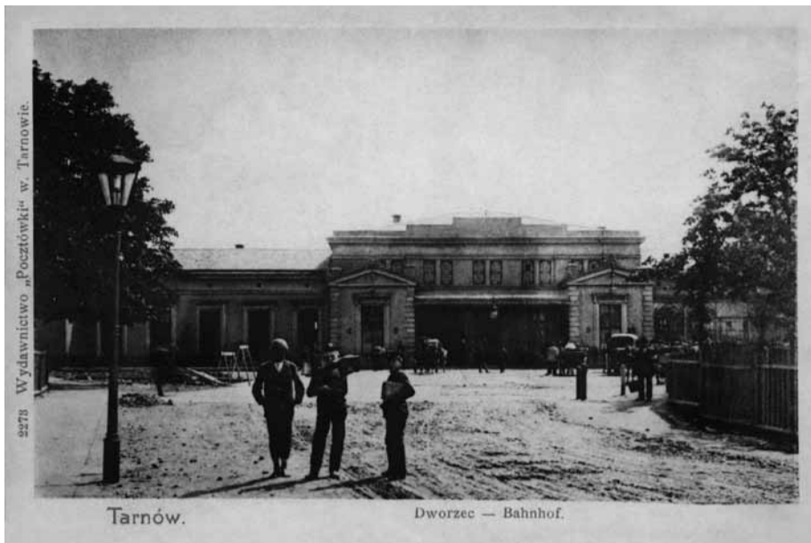
Stary dworzec kolejowy z lat 1860-1910
