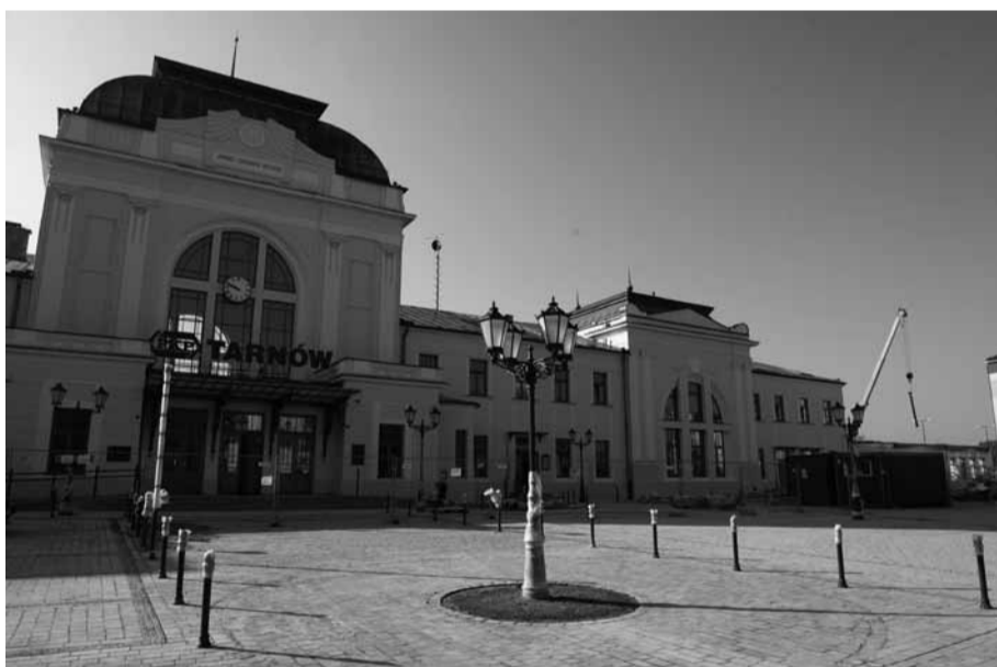
Rok 2010. Stuletni dworzec po remoncie
